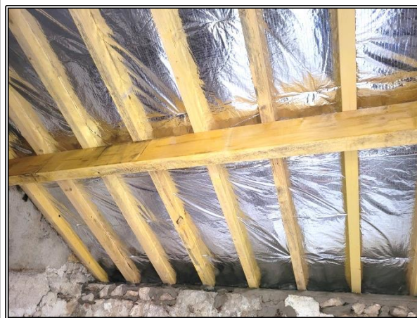
Détail intérieur avec isolant multicouches
