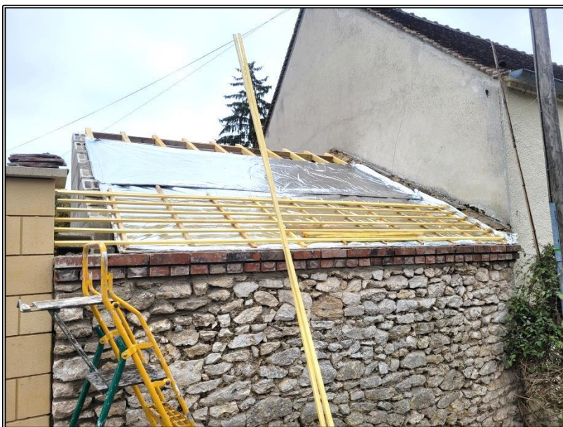
Opération lattage sur isolant multicouches
