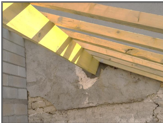
Pose des chevrons
