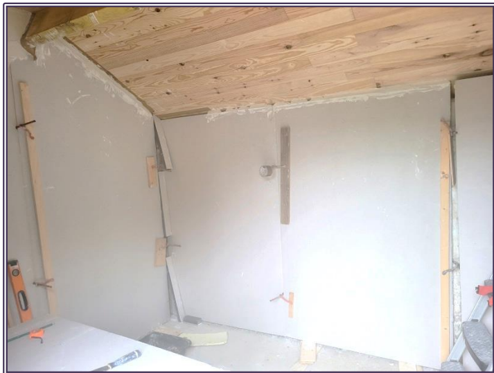
Doublage de 2 murs
