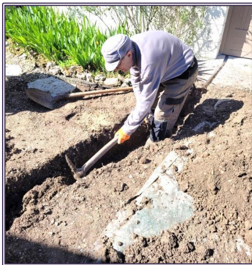
Réalisation d'une tranchée pour passage des câbles électriques
