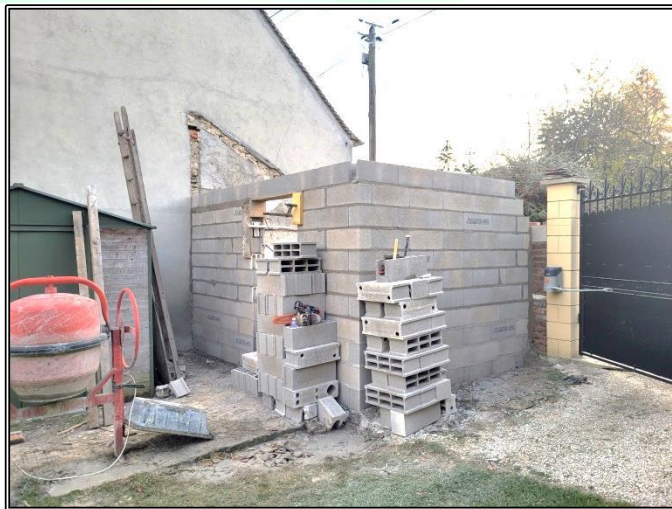
Réalisation du linteau et du ceinturage
