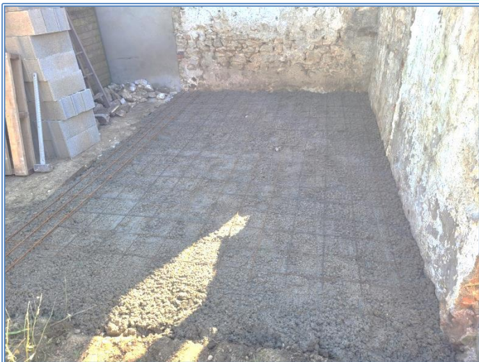
Coulage de la dalle
